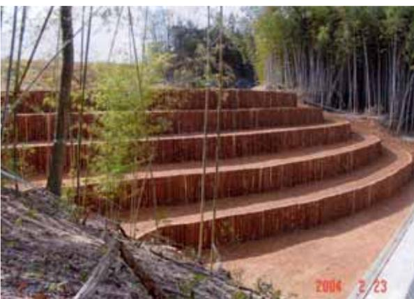
下の部分をのり先というが、山地のガレ場が雨で崩れ始めるとき、のり先から滑り始めることが多い。表層雪崩が上部から滑り始めるのとは少しイメージが違う。グリーンベンチの最下段の階段がこの滑り始めに対抗し、次の階段もその場で滑り始めに対抗することになる。
