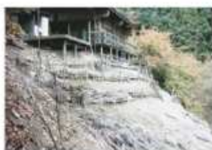
施工前の斜面
