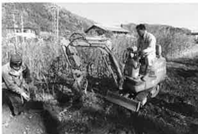
①掘り起こし バケットを根の下に直接入れて抜いた。
