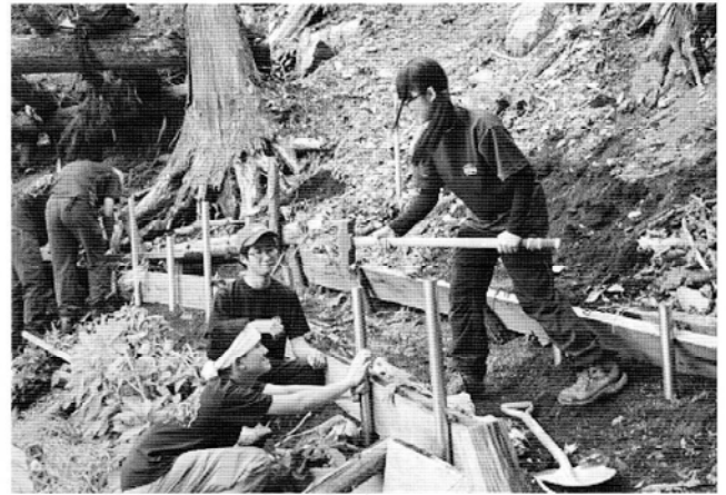
仁田小屋下のがけを修理する高校生
