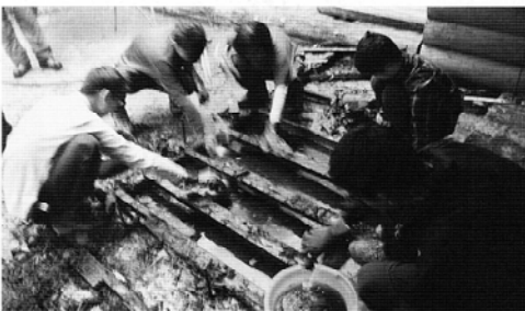
腐った汚水を抜き取る作業
