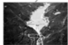
滝沢ダム 目的：F, N, W, P 堤高：132.0 m 竣工年：2011年
