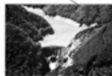
二瀬ダム 目的：F, N, P 堤高：95.0 m 竣工年：1961年
